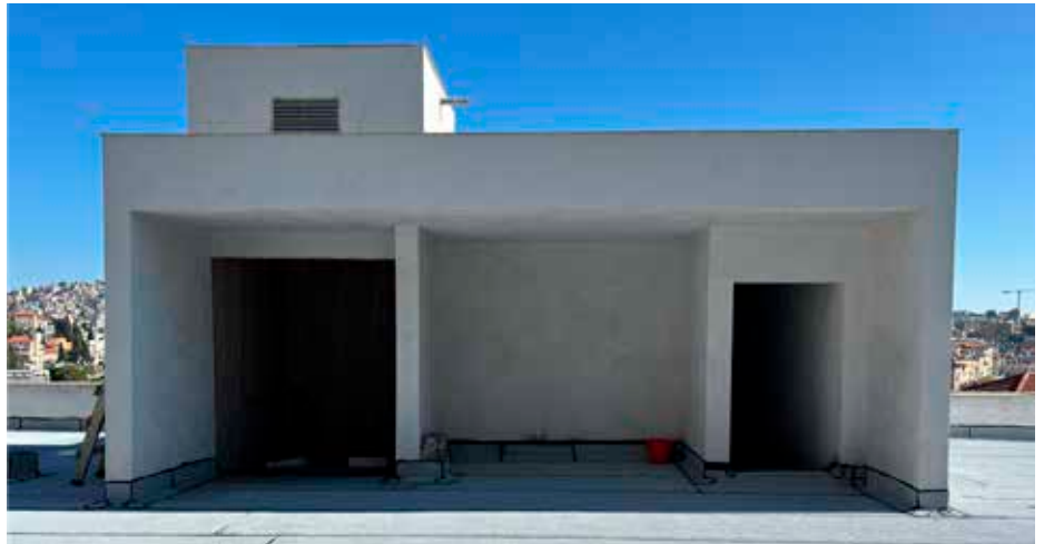
Der frisch verputzte Aufzugsschacht
