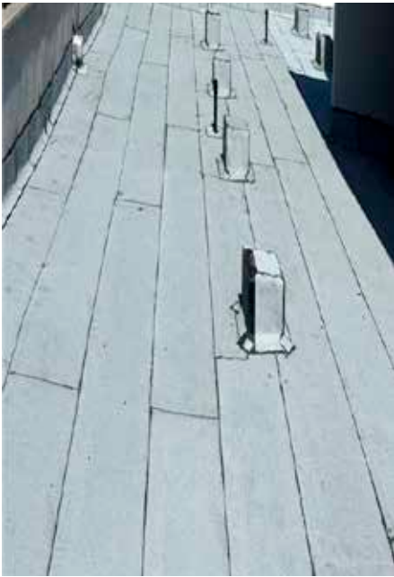
Das Dach wurde mit Teerpappe versiegelt
